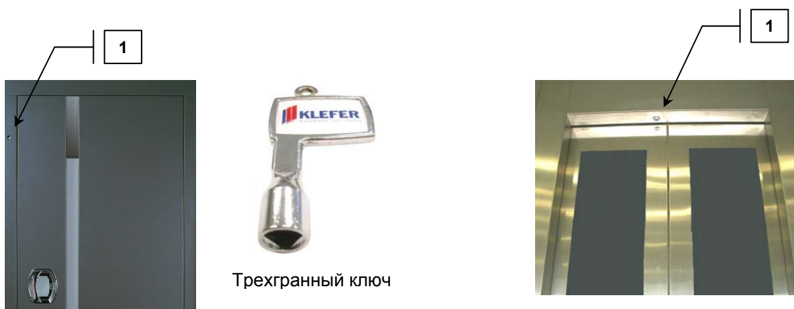
Рисунок 6: Разъем замка под трехгранный ключ в полу автоматической и автоматической двери
