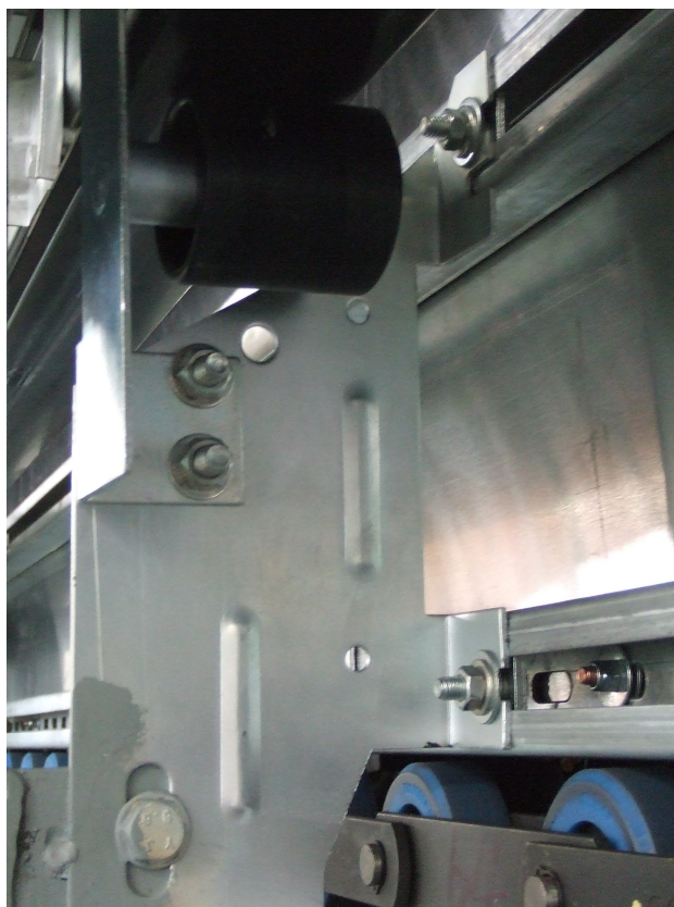
Рис. 4-7. Разборка боковой облицовки
